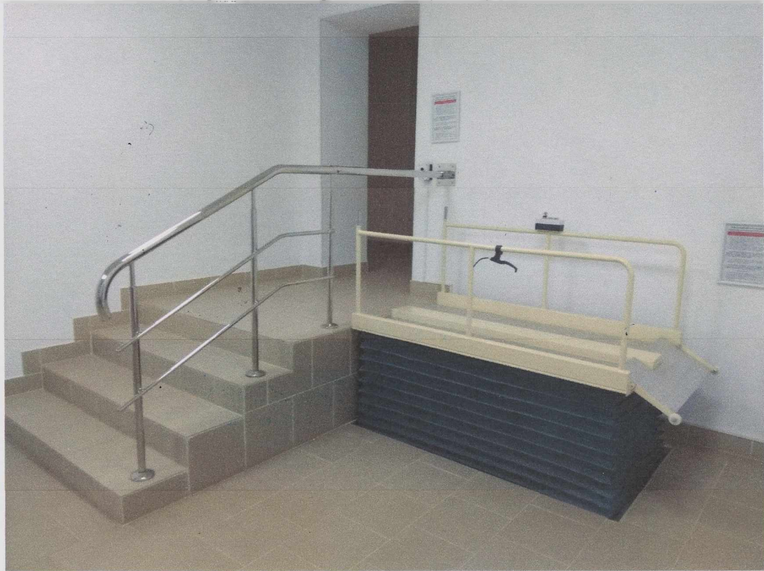
Фото №3 та 4. Пологове відділення. Влаштовано площадку підйомну ППН-1 (ПВК) для інвалідів та інших МГН
